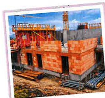
Aujourd'hui en chantier
